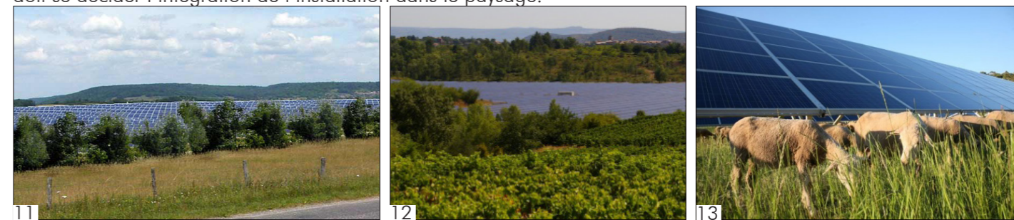
11 Exemples d'insertion paysagère multiple : de gauche à droite, haie champêtre de réduction des vues, respect de la trame et des motifs agro-paysagers, pâturage sous panneaux
